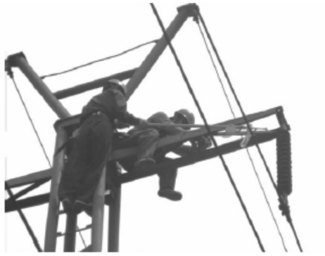
图 12 憎水性带电检测操作
